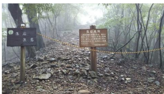
004 落石危険の男坂に虎ロープ
